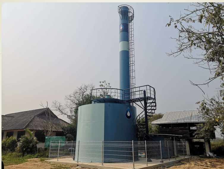
โครงการก่อสร้างระบบผลิตน้ำประปา POG TANK บ้านป่าเลี้ยว
