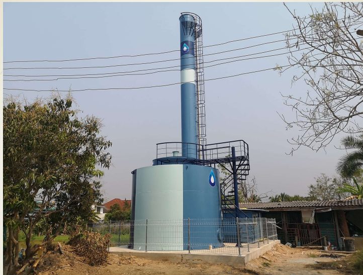
โครงการก่อสร้างระบบผลิตน้ำประปา POG TANK บ้านช่างคำ
